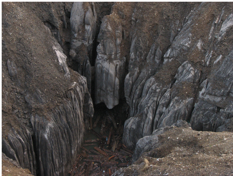
Рисунок 2 – Провалювання земної поверхні над виробкою відпрацьованих камер шахти смт. Солотвино
