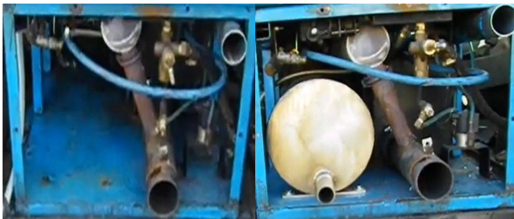
Рисунок 4 – Зовнішній вигляд контуру підігріву відпрацьованими газами агрегату для гідравлічного розриву пластів перед монтажем (а) та після монтажу (б) газорідинного теплообмінного апарату
