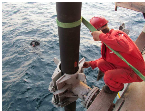
Рисунок 2 – Монтаж морського стояка в морі
