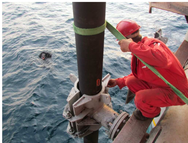
Рисунок 2 – Монтаж морського стояка в морі
