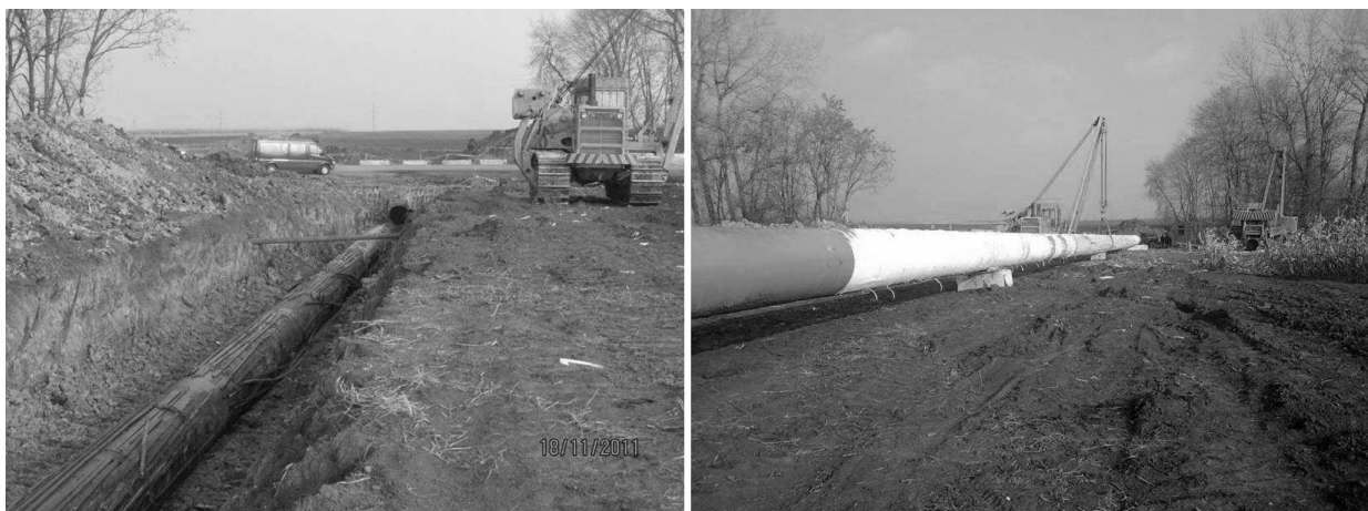
Рисунок 7 – Заміна переходу МГ КЗУ-І DN 1000 через а/д Тернопіль-Скалат за результатами первинної діагностики фірми “Розен”
