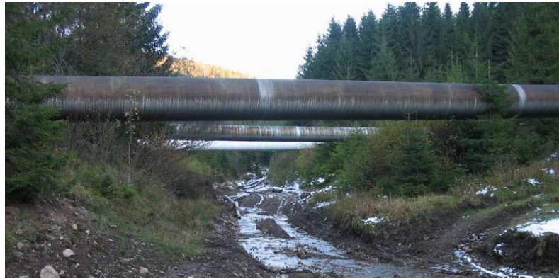
Рисунок 2 – Однопрогінні балкові надземні переходи МГ
